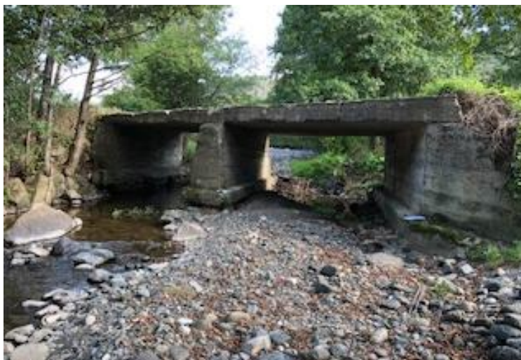
Figure 1 – Appearance of the bridge before rehabilitation Слика 1 – Изглед моста пре санације
