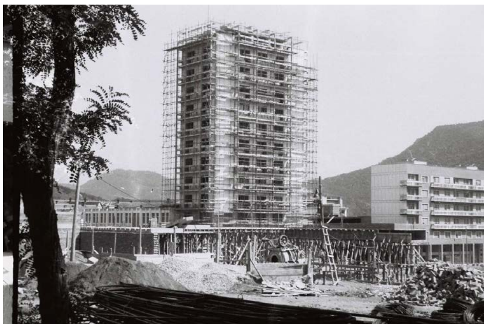
Слика 00. Објекат Куле, североисточни изглед, током изградње (1960)
