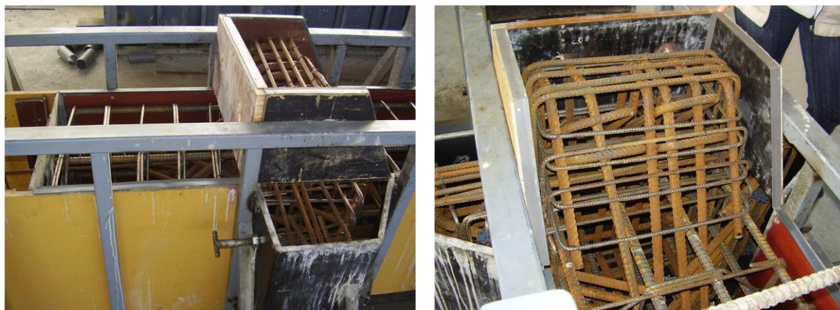
Slika 135. Armatura kratkog elementa u stubu
