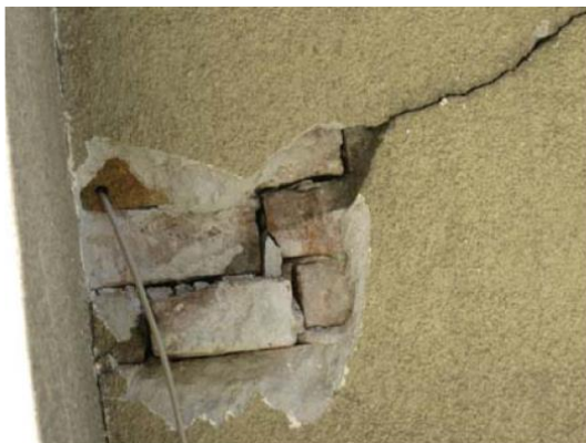
Слика 2. Пукотине на суседном објекту услед лошег осигурања темељне јаме новог објекта (слика 1)
