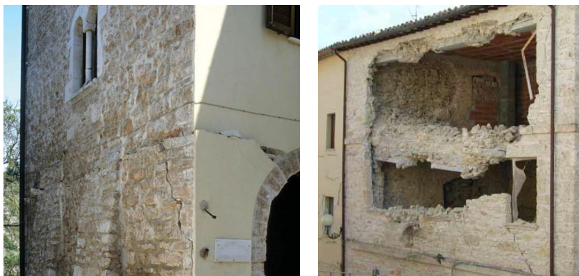
Слика 5. Последица замене постојеће међуспратне конструкције масивном армиранобетонском плочом [1],[3]
