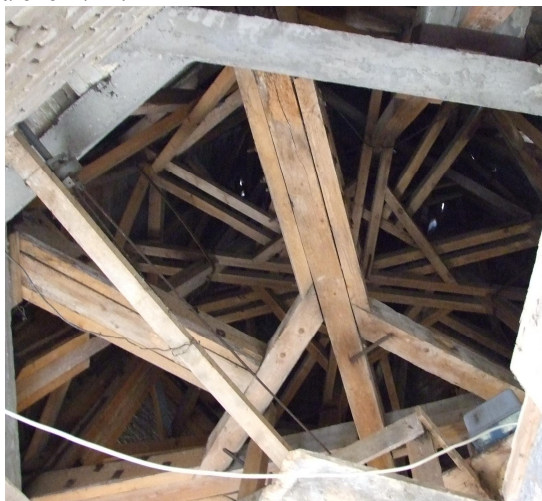
Слика 2. Кровна конструкција одоздо
